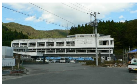
津波で損壊した校舎 2014 年に閉校
